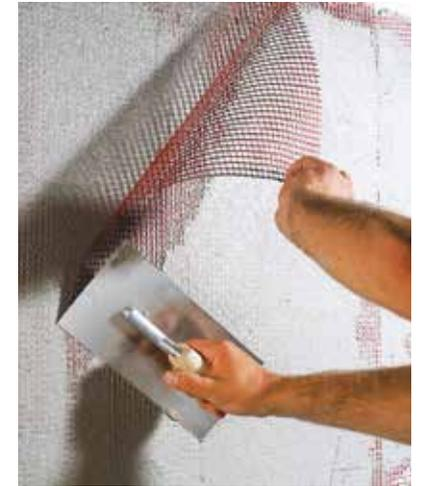
dabei, Spannungsspitzen abzubauen und trägt damit zur Vermeidung sichtbarer Risse im Oberputz bei. Heute ist es mehr und mehr üblich, Armierungsputze auch über die ganze Fläche aufzutragen und nicht nur an den besonders kritischen Stellen. Als Armierungsputze werden sowohl mineralische Trockenmörtel als auch organische Produkte angeboten.
